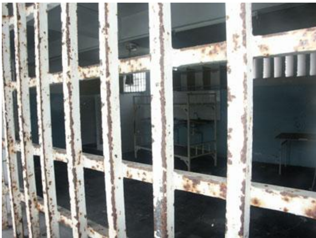
Ancienne maison d'arrêt de Pointe-à-Pitre (démolie)
