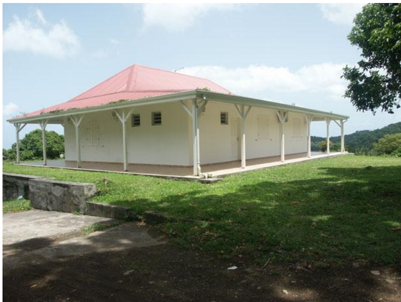
Club médical (chambre de garde médecin) Centre Hospitalier de Montéran
