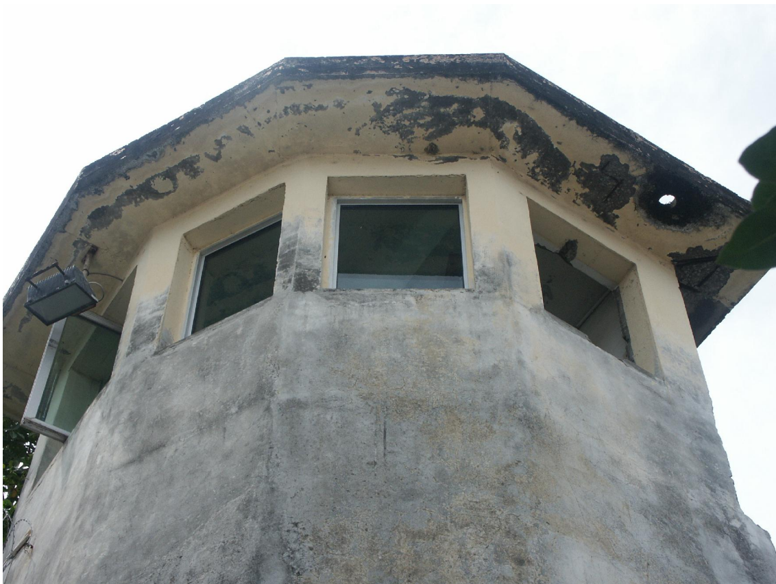
Mirador de l'ancienne maison d'arrêt de Pointe-à-Pitre (démolie)
